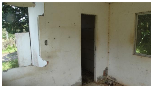
Vista interna da Guarita
