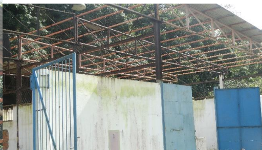
Galpões de Oficinas (1.500m2) (vistas da estrutura metálica sem telhas)
